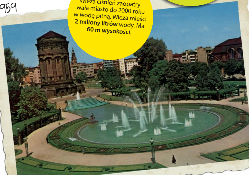
Wieża ciśnień z dachem zastępczym
