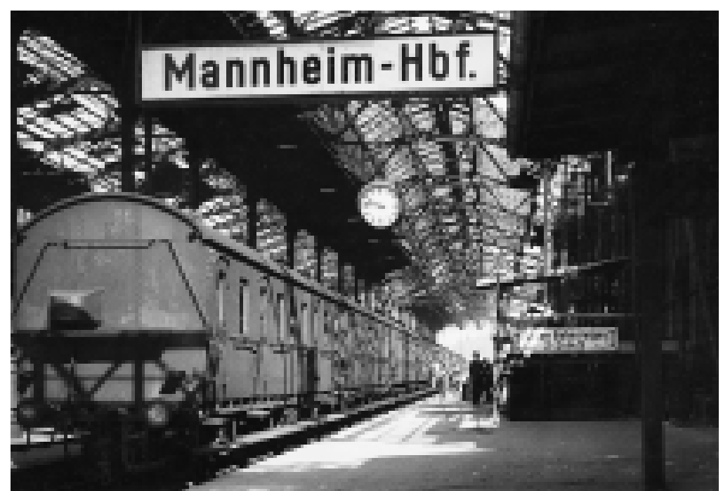
Im 2. Weltkrieg wird der Mannheimer Hauptbahnhof durch Bombenangriffe weitgehend zerstört. Noch 1949 ist die Überdachung der Bahnleise nicht wieder hergestellt.
