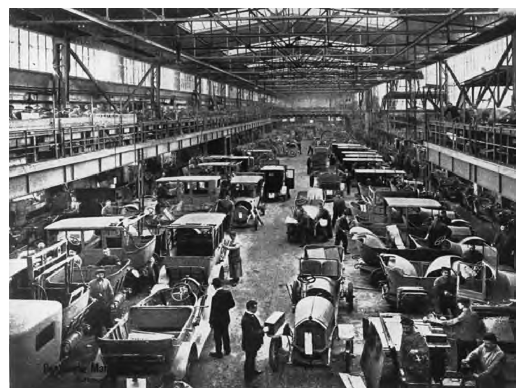
Karosseriemontage in der Benz'schen Motorenfabrik auf dem Waldhof, um 1910.
