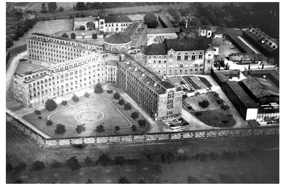
Das Landesgefängnis aus der Luft gesehen, 1927. Auf dem Gelände befindet sich heute neben einer Kirche, Bibliothek und Sporthalle ein großer Werkhallenkomplex mit rund 300 Arbeitsplätzen in allen Bereichen. Seit Ende der 1960er Jahre sind nur noch Männer in der Justizvollzugsanstalt untergebracht. 2009 sind rund 755 Personen inhaftiert.
