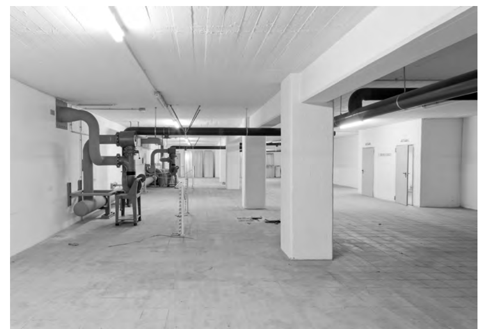
In der Zeit des Kalten Krieges werden bei der Instandsetzung des Bunkers zum Schutz vor ABC-Waffen die alten Bunkerzellen entfernt und neue Lüftungs- und Filtersysteme eingebaut. Dazu wird ein über zwei Geschosse reichender Anbau mit Sand gefüllt. Er ist heute von außen farblich abgesetzt.
