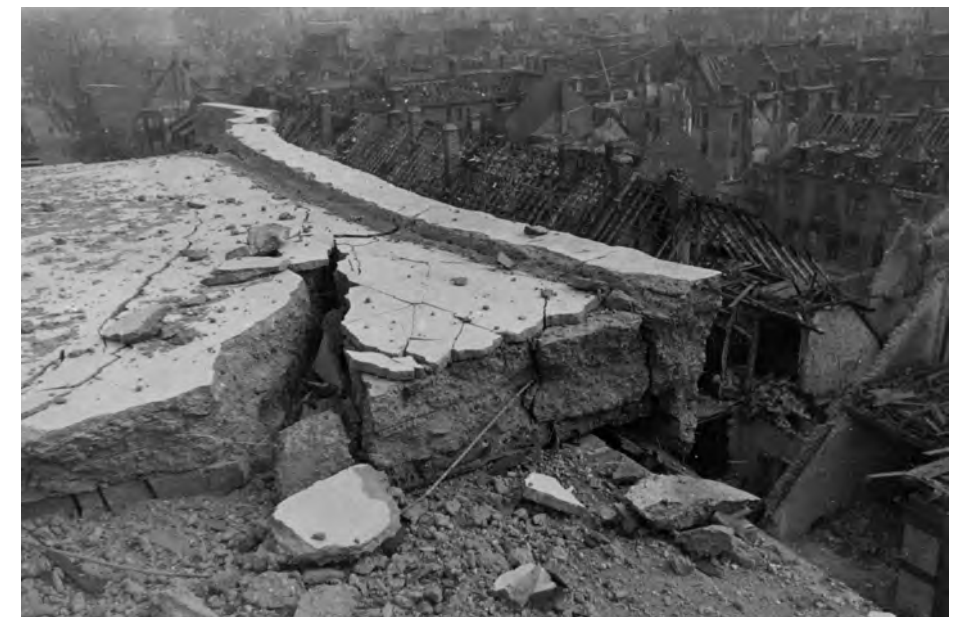
Bombentreffer des Bunkerdaches, dahinter die stark beschädigten Gebäude der Bürgermeister-Fuchs-Straße. Foto aus einem Bericht des Hochbauamtes von 1944.
